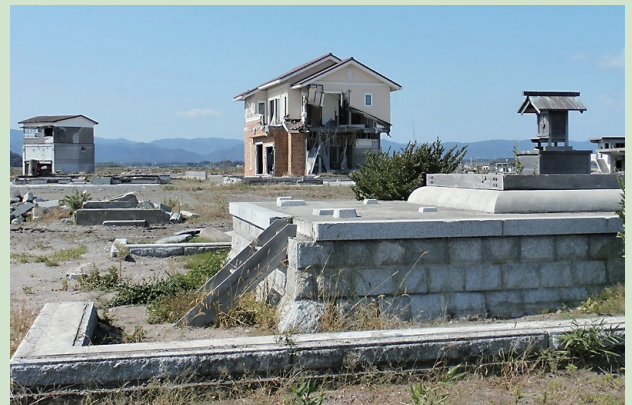
被災直後とあまり変わらない光景が拡がる 茗野(くさの)神社(波江町)
